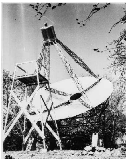
Figure 3. Antena de 9 m diseñada y usada por Grote Reber
